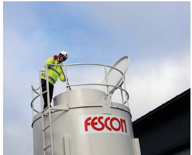
Työmaasiilon täyttämisen jälkeen täyttöluukun kansi tulee puhdistaa ja sulkea huolellisesti.
