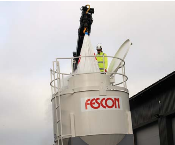
Fescon Oy:n järjestämissä kuljetuksissa siilon täyttöön tarvitaan aina työmaalta vastaanottaja siilon päälle.
