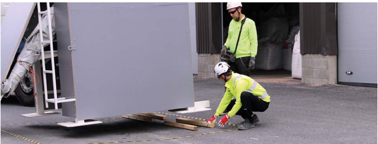
Työmaasiilo asennetaan kahden asteen kulmaan putkisekoittajan suuntaisesti.
